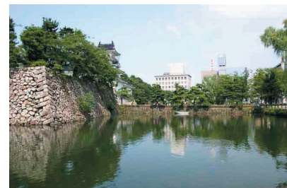
堀・土橋・石垣
