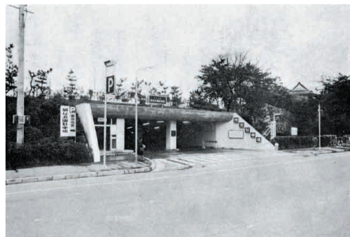
開業当時の駐車場入口
