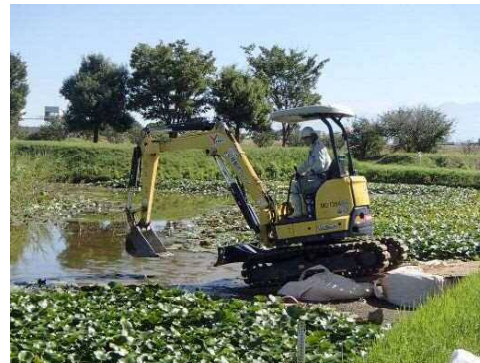
写真 9.1.8 重機搬入状況
