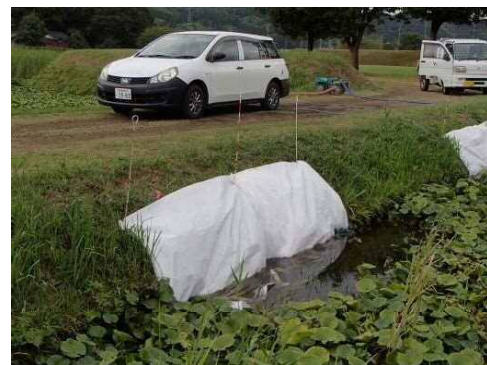
写真 9.1.4 養生シートによる止水
