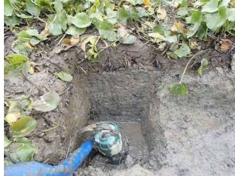
写真 9.1.16 サブトレンチ掘削
