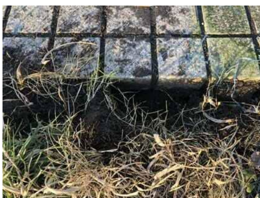
写真 9.6.3 土塁展示施設頂版境界部
