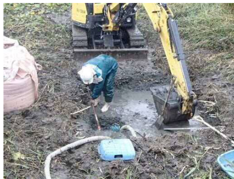
写真 9.1.10 トレンチ掘削状況(人力)
