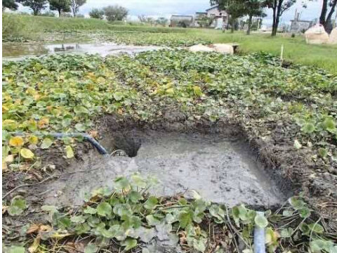
写真 9.1.15 トレンチ掘削状況
