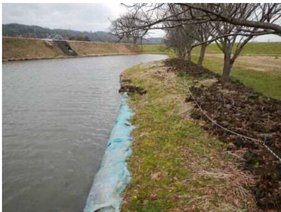
写真 9.2.1 堀の護岸状況(護岸補修箇所)
