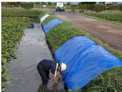
写真 9.1.3 養生シートによる止水
