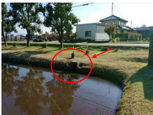
写真 9.2.4 給水口の状況写真(遠景)
