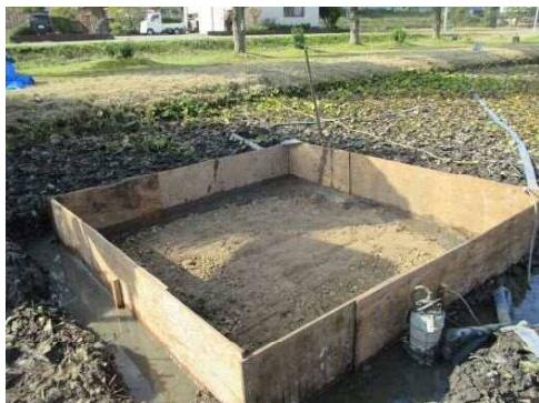
写真 9.1.13 型枠設置状況
