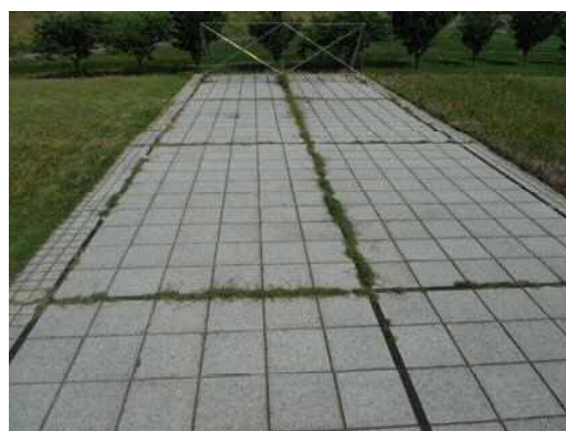
写真 9.6.2 土塁展示施設頂版外面伸縮目地
