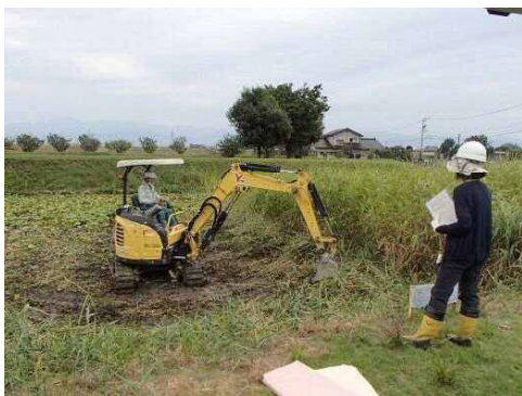
写真 9.1.9 トレンチ掘削状況(機械)
