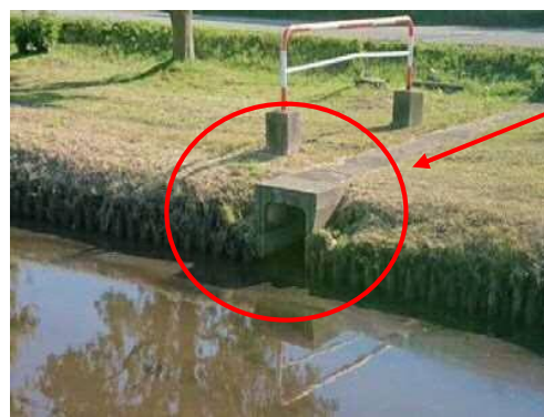
写真 9.2.5 給水口の状況写真(近景)
