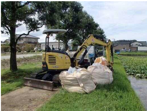
写真 9.1.7 重機搬入状況(スロープ設置)
