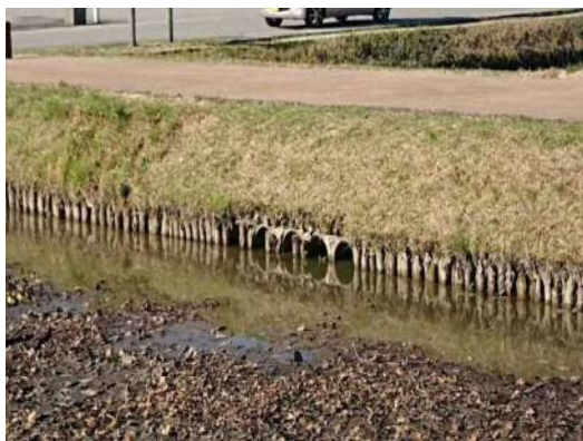
写真 9.2.8 土橋暗渠の状況
