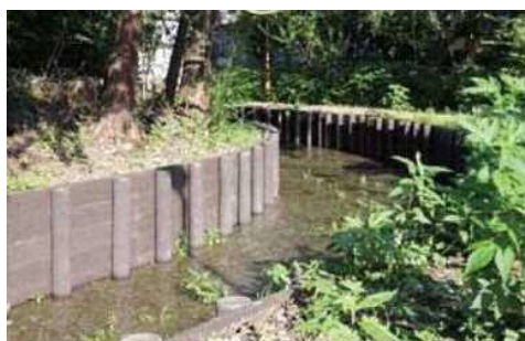
写真 9.2.3 板柵土留施工事例
