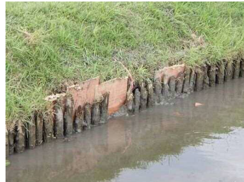
写真 9.1.2 型枠用合板による止水
