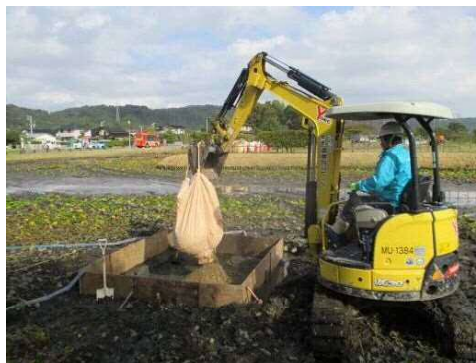
写真 9.1.14 埋戻し作業状況
