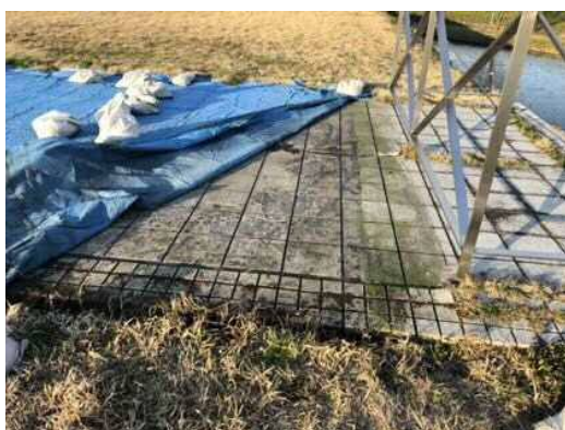
写真 9.6.1 土塁展示施設頂版外面
