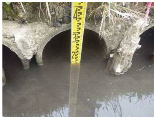
写真 9.2.9 土橋暗渠径(ヒューム管φ300)
