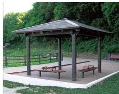
図 9.7.4 東屋形式休憩施設例（ベタ基礎、プラ擬木、方形スタイル）
