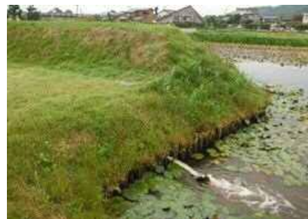
写真4-13 地下水ポンプによる堀への給水状況（二の丸給水口）
