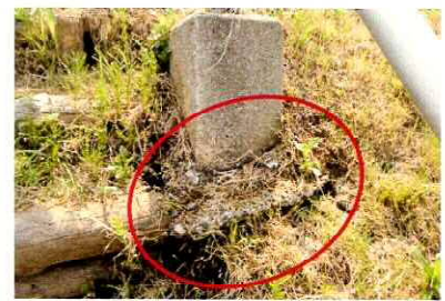
⑥本丸土塁階段 土砂流出状況
