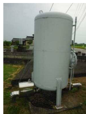
写真4-12 地下水ポンプ
