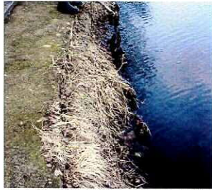
①-1 堀 護岸の浸食と松杭の劣化状況
