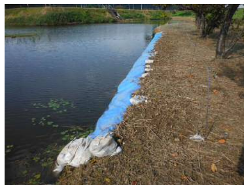
写真 4-8 漏水箇所の応急処置状況
