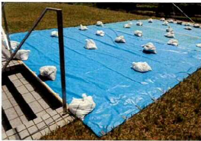
⑤-1 土塁展示施設 屋上防水応急処置状況
