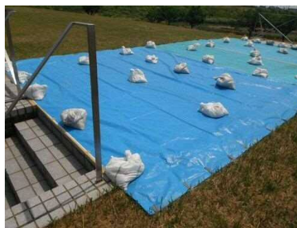
写真 4-23 屋上の応急処理の状況
