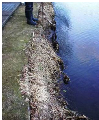
写真 4-10 護岸の浸食と松杭の腐朽
