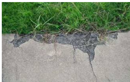
写真 4-29 H19 アスファルト舗装のひび割れ
