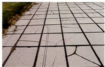
⑨野外模型の亀裂状況
