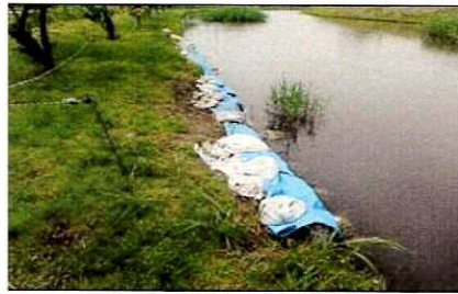
①-2 堀 漏水箇所応急処置状況
