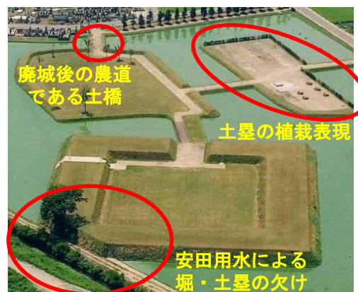
写真 4-38 サインによる説明が必要な箇所
