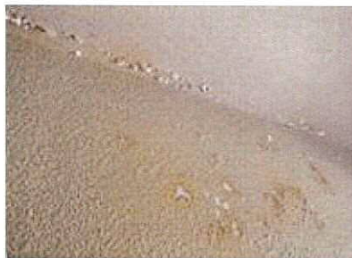
⑤-2 土塁展示施設 天井塗装剥離状況
