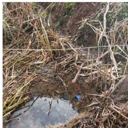
写真 4-33 ヨシの根茎が右郭の法面まで伸びている状況 (青い管は地下水ポンプの給水管)
