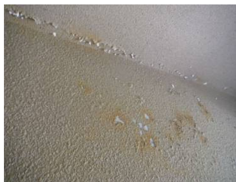
写真 4-21 施設内の塗装の剥離
