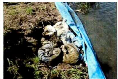
①-3 堀 護岸陥没穴応急処置状況
