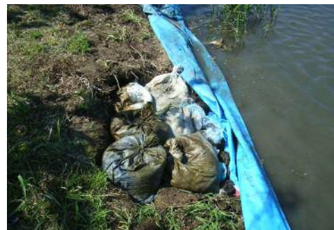
写真 4-9 護岸陥没穴応急処置状況
