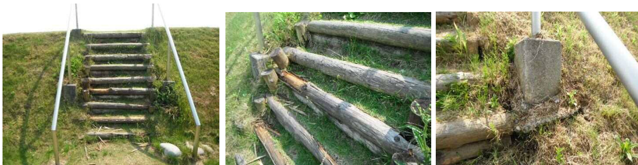
写真4-25 木製階段の劣化状況
