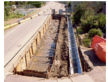
写真 1 堀の発掘状況
