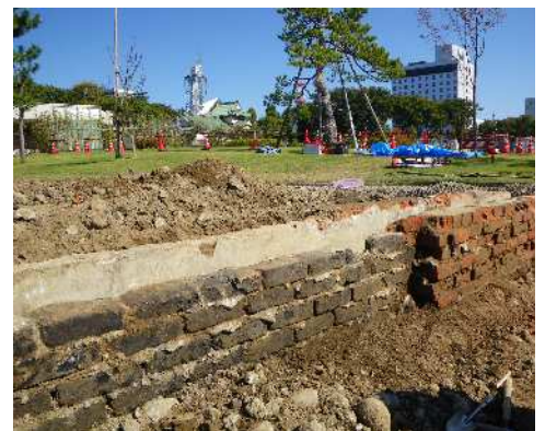
一部黒レンガ積みの溝跡
