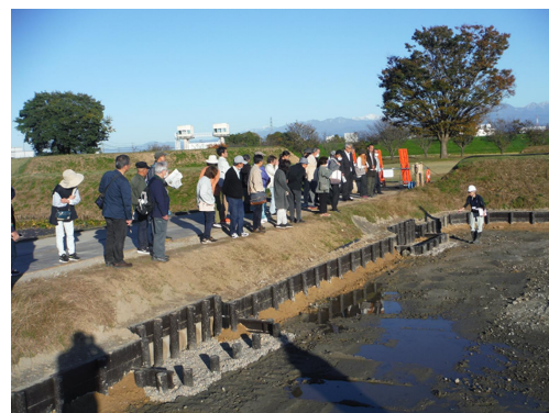
昨年の工事現場見学の様子
