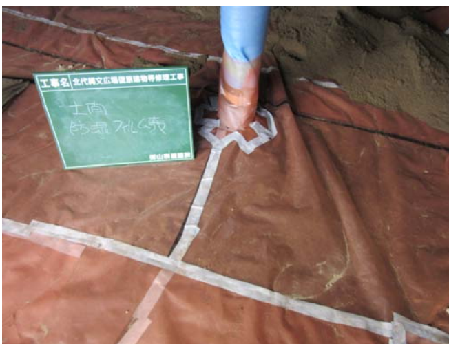
第70号住居の地下水等対策
