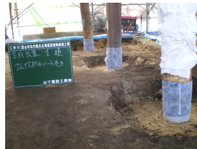
高床倉庫の木部保護対策：第1号掘立柱建物
