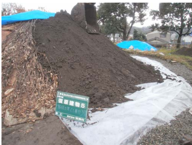
縦穴住居のシート排水：第13号住居（複製）
