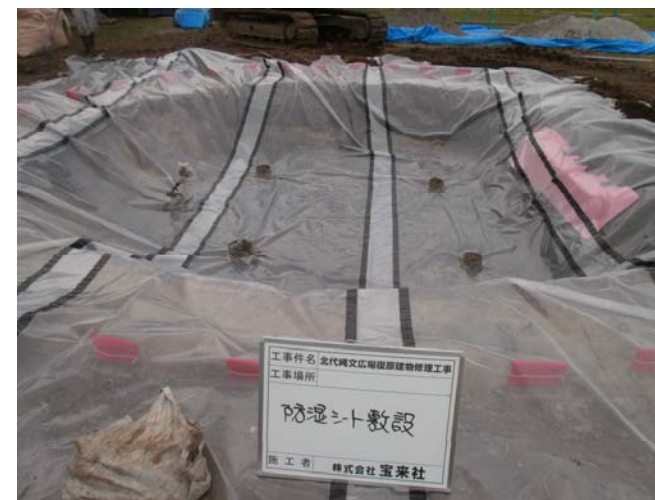
第1号住居（複製）の地下水等対策
