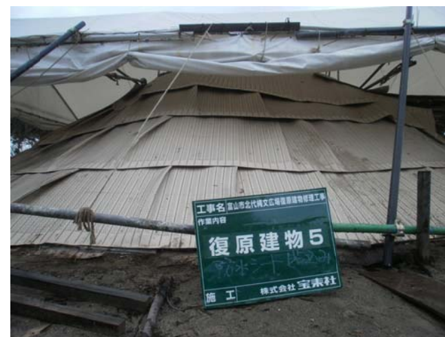
竪穴住居の雨漏り対策：第 13 号住居（複製）
