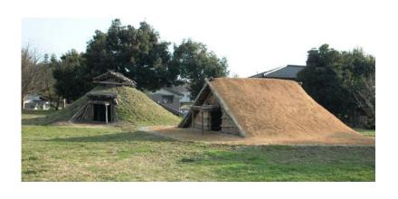
じたうえで土間を叩き仕上げとしました。土間叩きは縄文時代の竪穴住居跡でも多く確認されており、地下水の染み出し防止や湿度コントロールのための縄文人の工夫でした。今回は土間叩きとあわせ、屋根下地層と腰壁に吸放湿性能をもつ特殊資材を敷設して湿度環境を大幅に改善することに成功しました。
