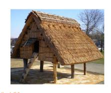
以上を踏まえ、今回は**茅葺法を維持管理(差し茅)できる順葺に変更し、従来の約3 倍に及ぶ量のすぐり茅で設葺**して雨漏り対策を万全にしました。また、強度が著しく低下 した**梯子材と主柱材2本を取替え**ました。取替えなかった材を含め、**丸太材の地下埋設部 分には防湿シートなどで防腐対策を講じた**ほか、雨水がしたたり落ちた場合に備えて銅板を巻き付けました。これは、**発生した銅イオンによる抗菌効果を期待**したものです。
