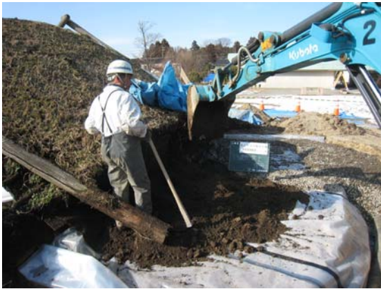
防湿シート敷設
