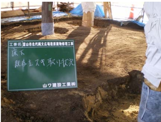
劣化材（主柱）取替・主柱基部養生
