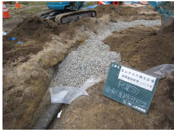
透水管周囲補修
