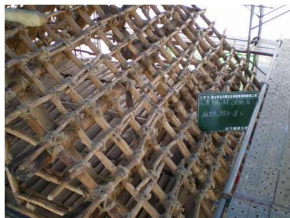
劣化材（小屋組材）取替・再結束
