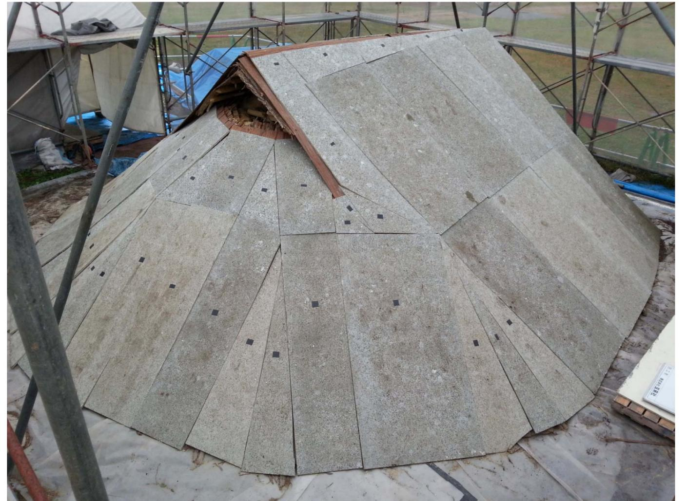
壁の仕上げに使った特殊な材料を、屋根土を支える下地材の片面にも塗ったんだ。乾いて白くなったところがその材料で、最大の効果を発揮するのは4mmの厚さで仕上げたときなんだって。
