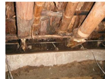
屋根材の折損、腐朽
