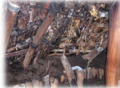
屋根材の腐朽、折損
