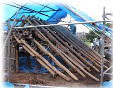
大型の第70号住居では、屋根材を二重にして、屋根土や積雪からの荷重を分散させています。
