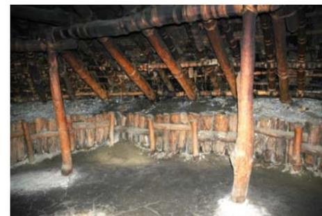
雨漏り、堰板等の腐朽（24年度）
