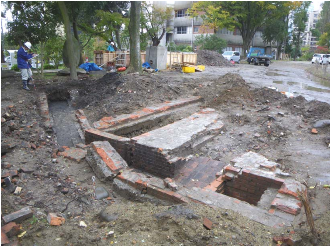
②付属建物（工事のため、埋め戻し済）
