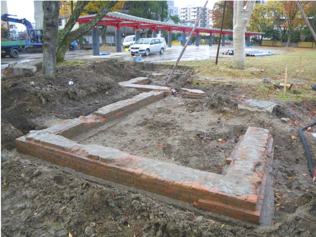
①旧県会議事堂(西棟)建物土台
