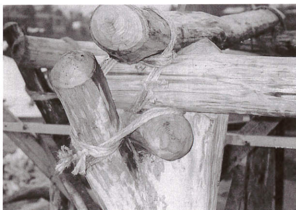
梁 麻縄結束状況
