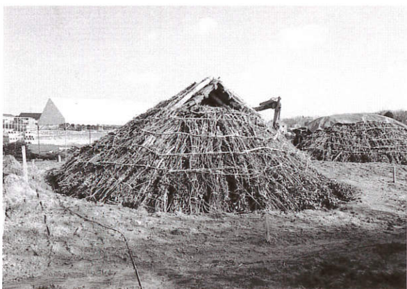
そだ木敷完了
