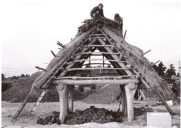
屋根茅葺・棟樹皮止め作業
