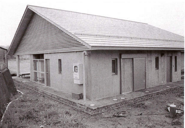
倉庫・機械室・WC
