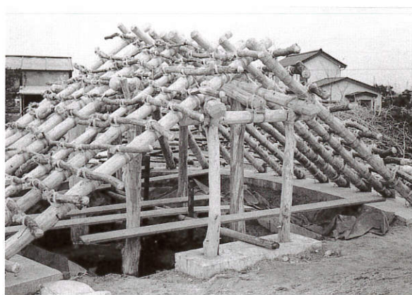
小舞取付 (復原建物6)
