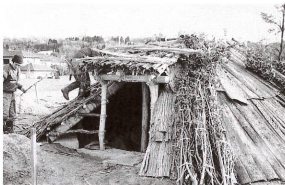
そだ木敷き・樹皮敷き
