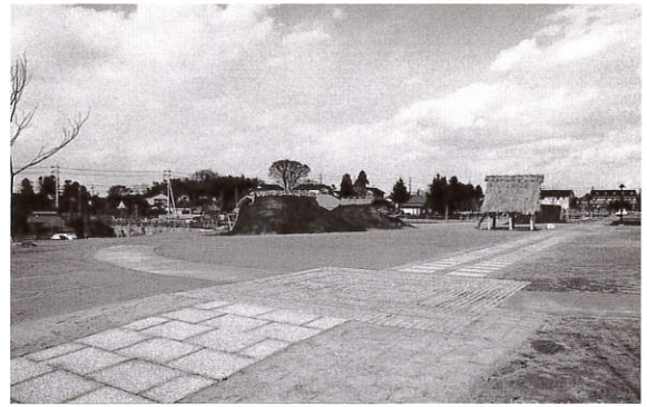
小舗石舗装・板石舗装・砂舗装
