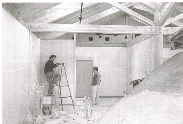
仕切りパネル製作
