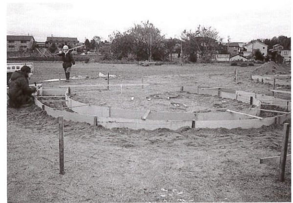
基礎コンクリート型枠組み
