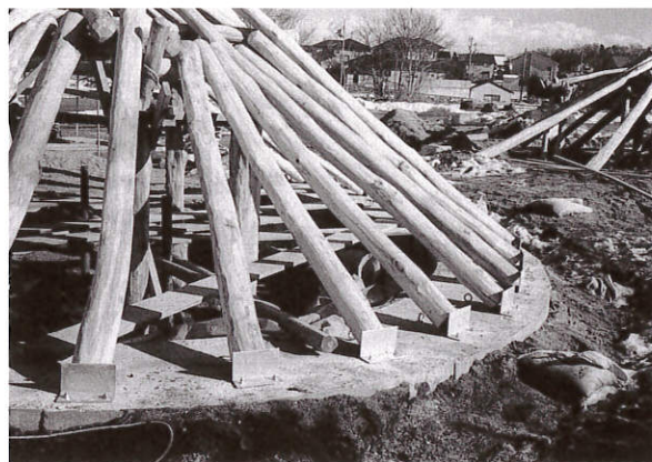
垂木止め (ボルト止め)
