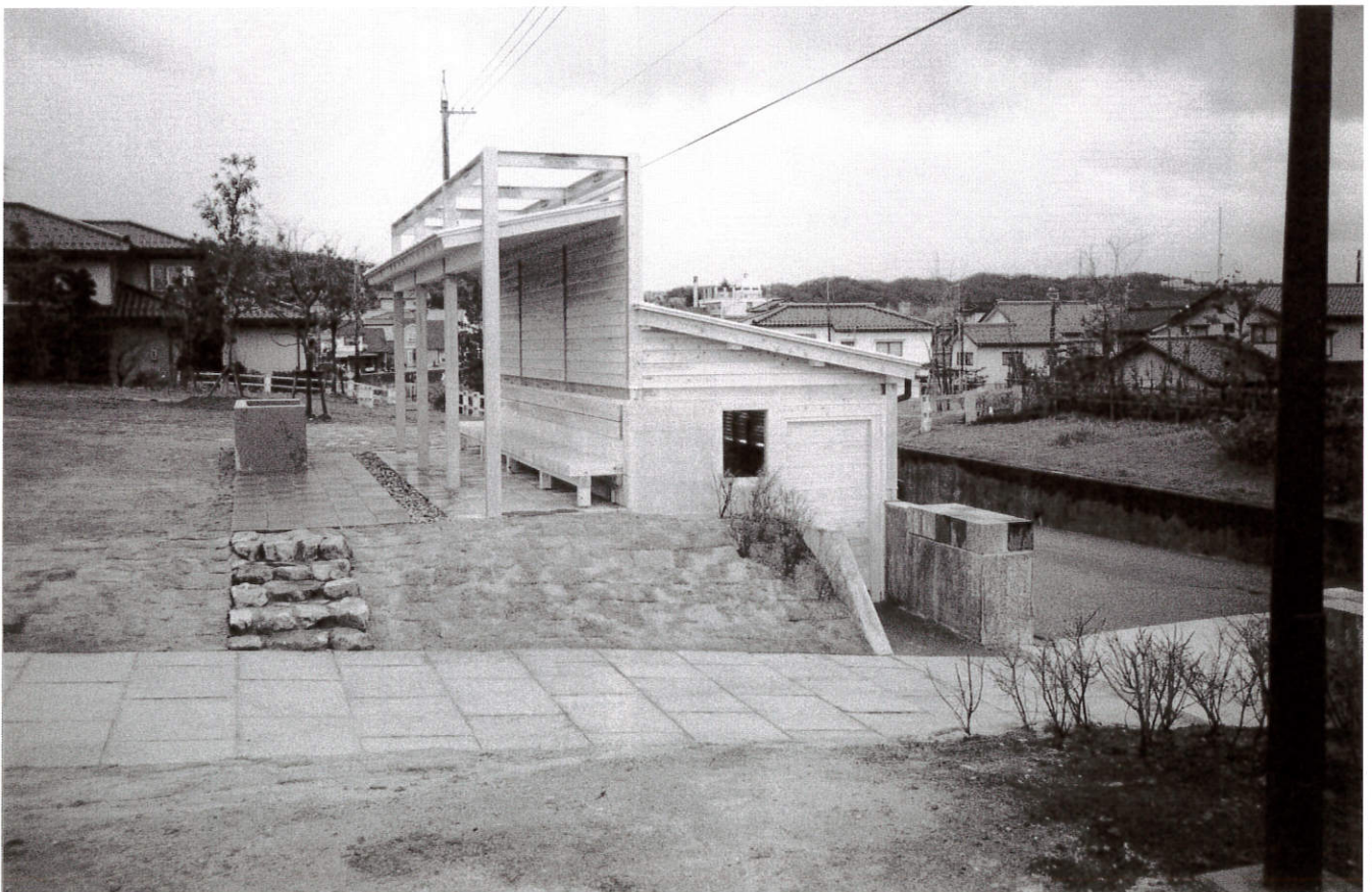
PL.43 土層展示場 完成（北東から）
