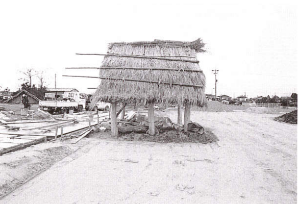
屋根茅葺・棟樹皮止め
