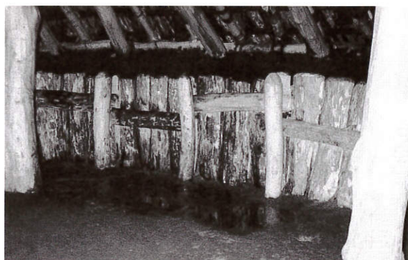
竪穴住居内壁面堰丸太（復原建物3）
