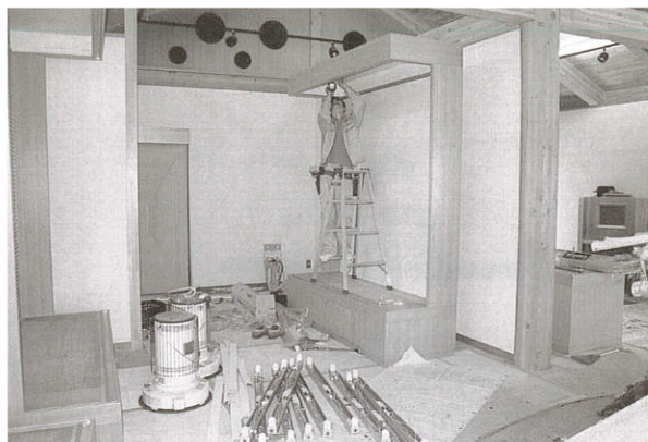
展示ケース取付け作業
