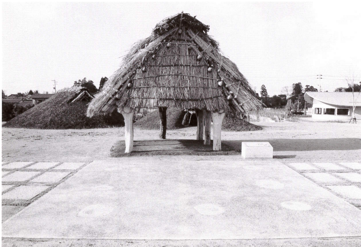
PL.39 復原建物 4（第1号高床建物） 手前は第2号高床建物の平面表示
