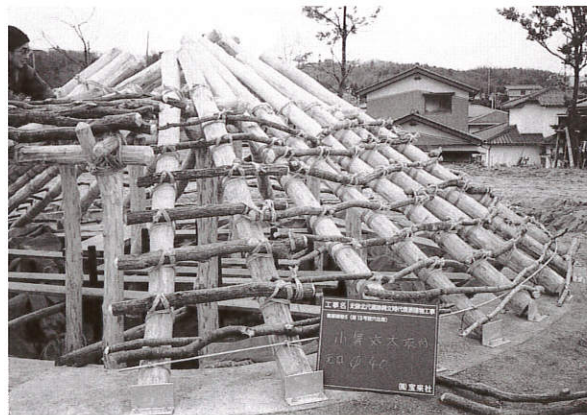
小舞取付 (復原建物5)
