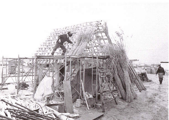
屋根茅葺作業
