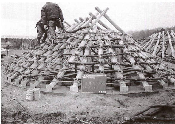
小舞取付 (復原建物6)
