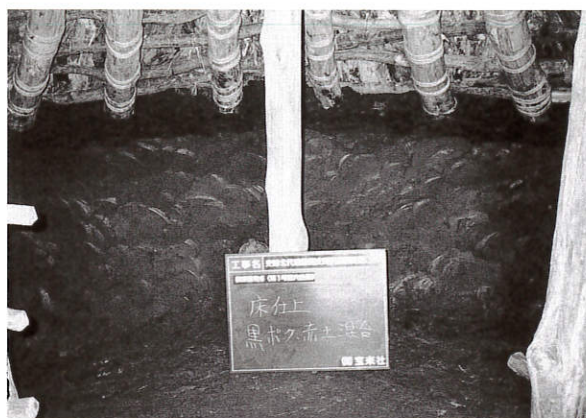
竪穴住居内床・壁仕上げ
