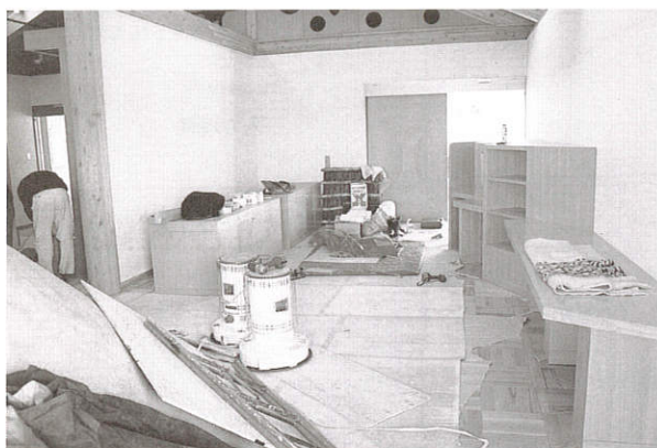
展示ケース取付け作業
