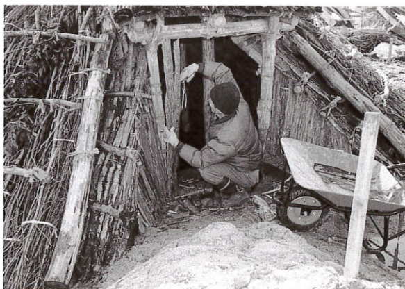
入口部樹皮取付 (復原建物5)
