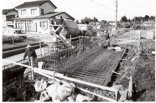
鉄筋組み
