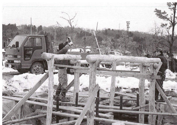
主柱建方・梁接合
