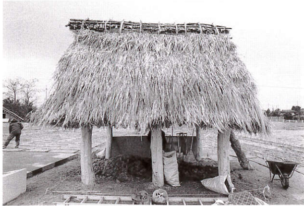
屋根葺上げ完了
