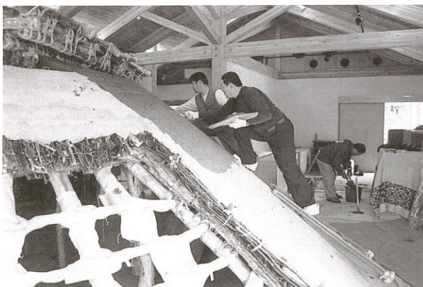
住居屋根モルタル塗付作業
