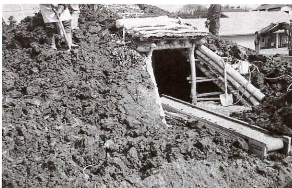
屋根及び住居内の土整形
