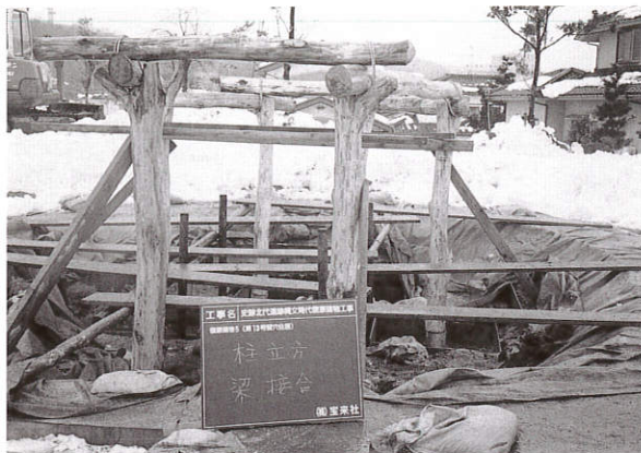
主柱建方・梁接合
