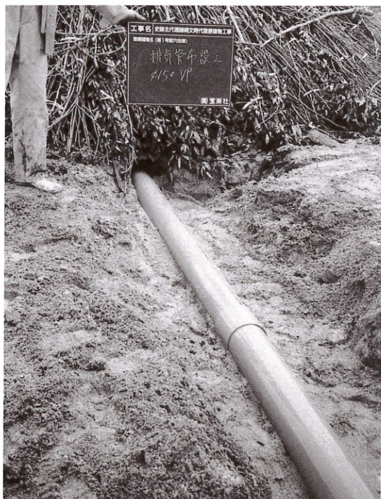
復原建物6 排気管埋設
