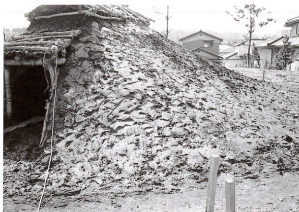
竪穴住居葺土表面仕上げ（復原建物5）
