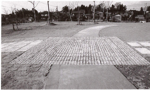
小舗石舗装（南から）
