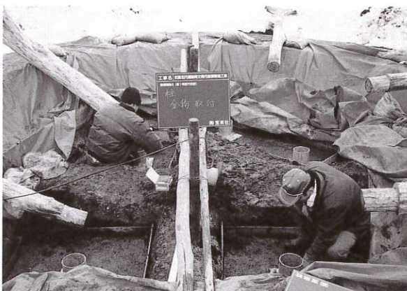
主柱金物取付
