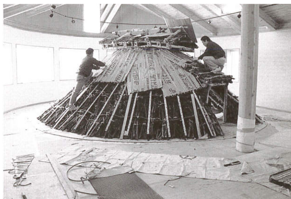
竪穴住居製作作業
