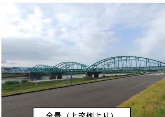
全景（上流側より）
