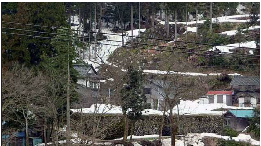
八尾町青根地区（地すべり対策事業）
