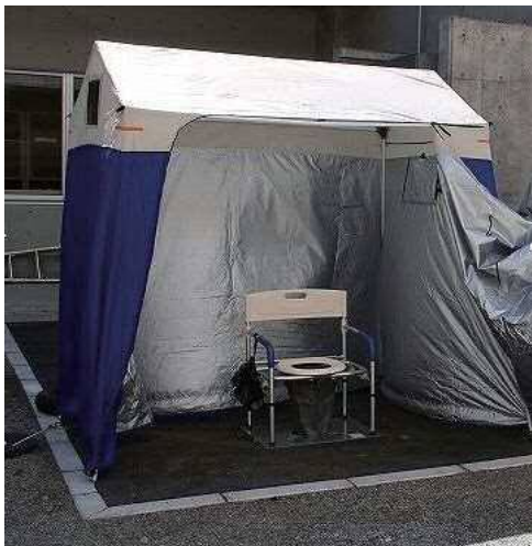
平成29年9月に完成したマンホールトイレ
