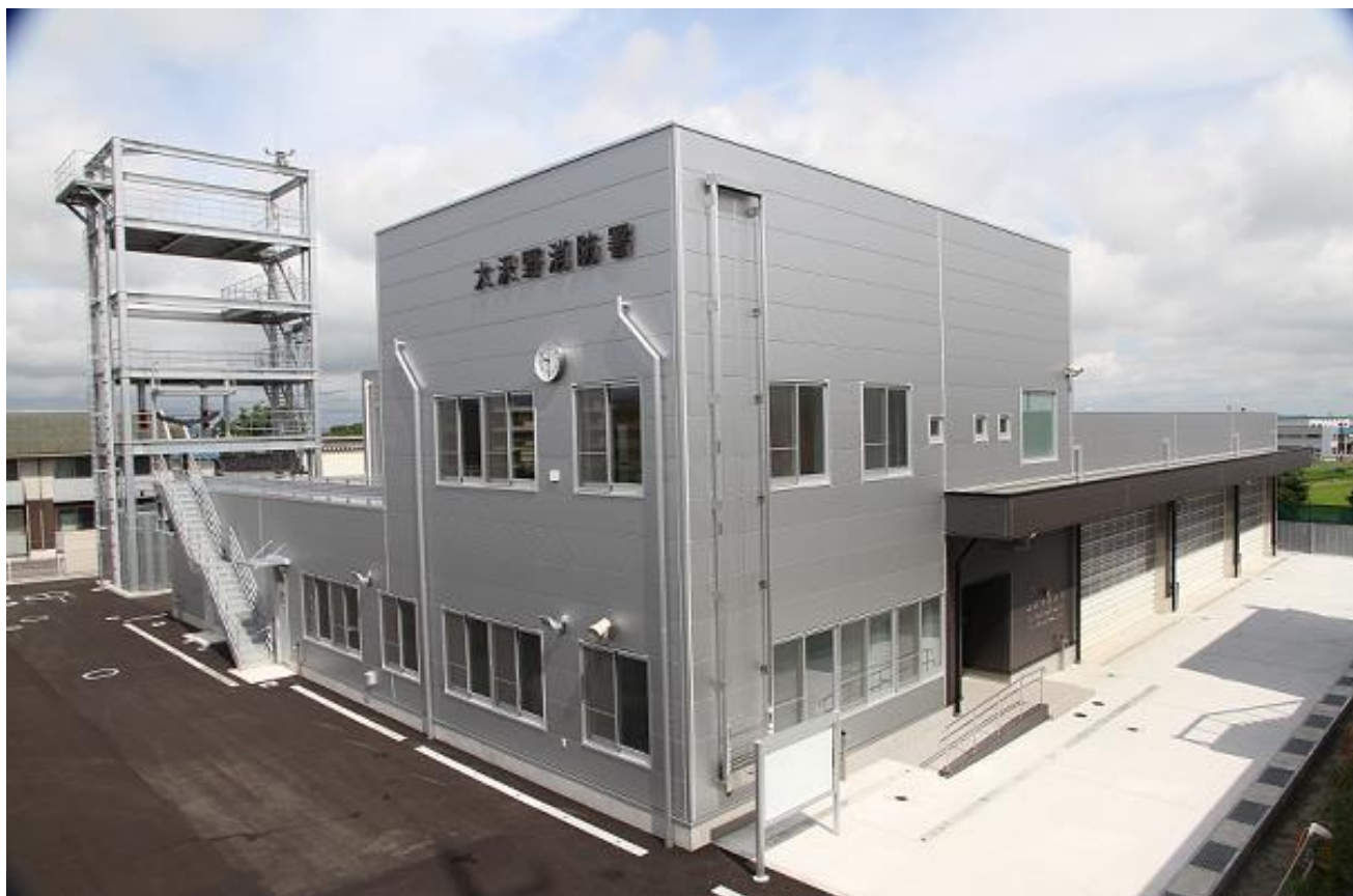
大沢野消防署 新庁舎（令和2年7月運用開始）
