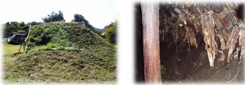
写真1 土屋根の陥没（左）と屋内の屋根土流入・屋根下地劣化状態（右）
