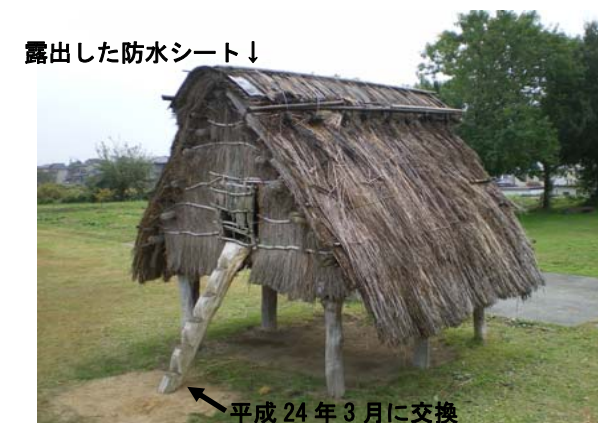
第 2 回修理前（平成 24 年 11 月）
