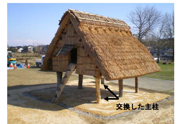
第 2 回修理後（平成 25 年 3 月）
