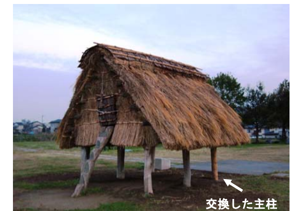
第 1 回修理後（平成 16 年 11 月）
