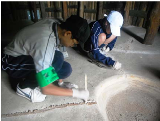
調査した土間の補修材料を亀裂に充填
