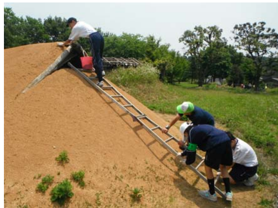
赤土屋根表面の崩落部分に屋根土を充填
