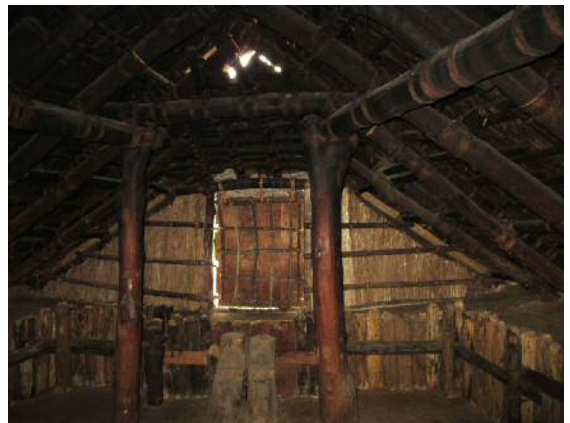
修理工事後(内観)
