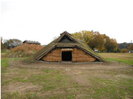
修理工事後(外観)
