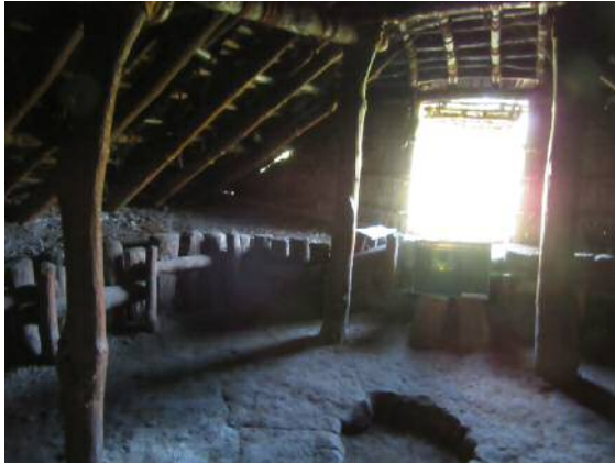
修理工事前(内観)
