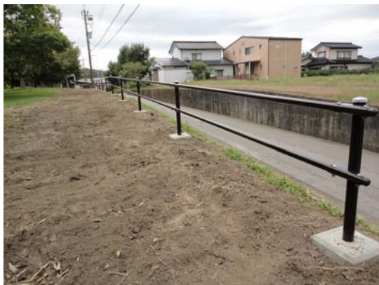
木柵から更新した金属製横断防止柵（右側の写真奥は木柵）
