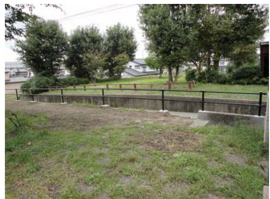
木柵から更新した金属製横断防止柵（右側の写真奥は木柵）
