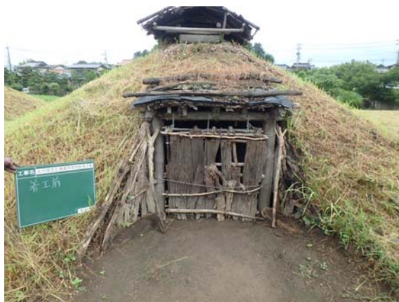
修理工事前（外観）
