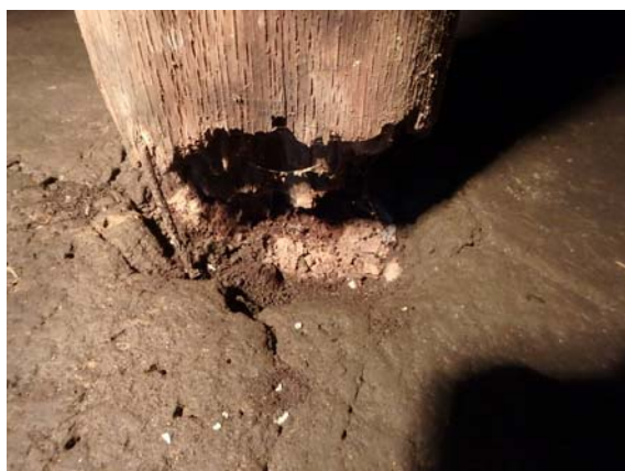
修理工事前（支柱基部）
