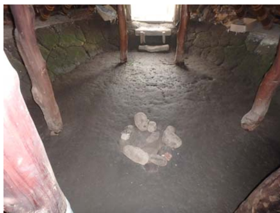
修理工事前（内観）
