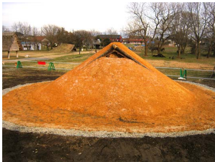
厚さ 15cm の土屋根は、最下層を全面軽石（大粒）層にして丸太材にかかる荷重を軽減させました。中層には小矢部市産の赤土と軽石（中粒）を混ぜて叩き締め、上層は赤土と軽石（細粒）を混ぜて叩き締めました。軽石は浸透した水を排出する空隙があり、これによって屋根土内を乾かすことができます。軽石には保水性もあり、夏季には散水することで屋根表面の細粒が若干の水分を保ち、赤土の亀裂を防ぐことにしました。
