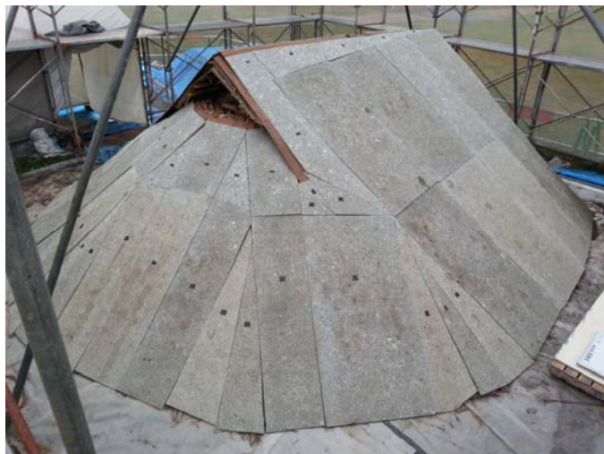
クリ・スギ樹皮葺き後、内側に吸放湿性能をもつ塗壁材を塗った木毛セメント板を敷設し、屋内の湿度環境を改善させると共に屋根の下地材としました。
