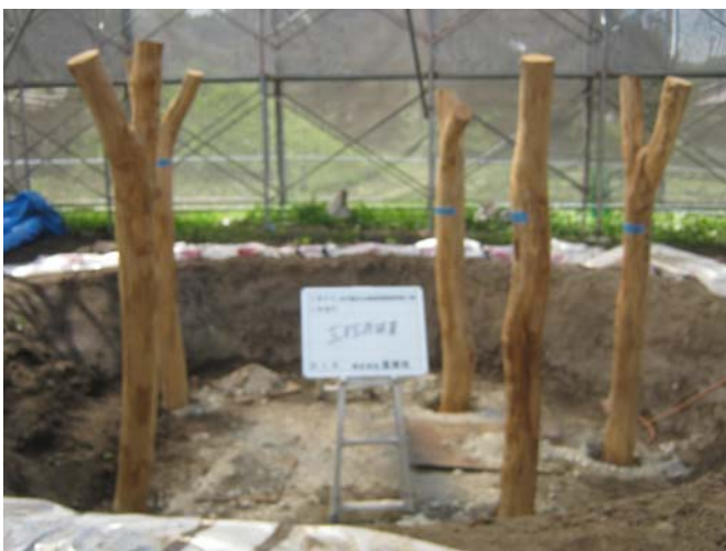
地下の水・湿気を通さないシートの上にセメント改良した黒土を置き、腰壁の下地とします。
