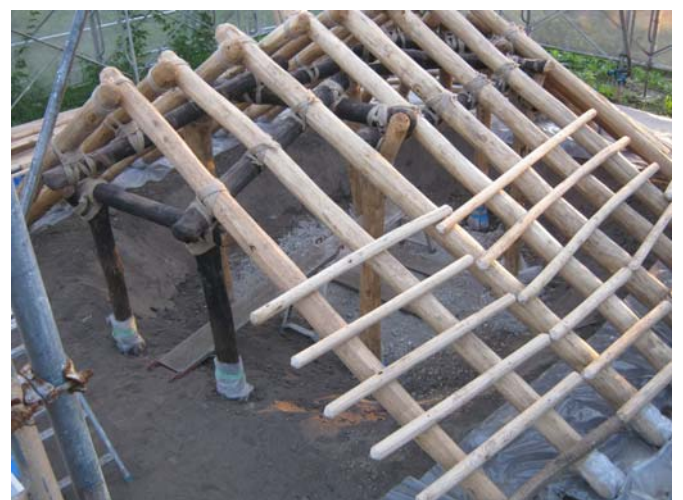
桁・梁など再利用／転用可能な丸太材等を用いて小屋組します。土中に埋まる部分は水や木材腐朽菌からシートで保護します。
