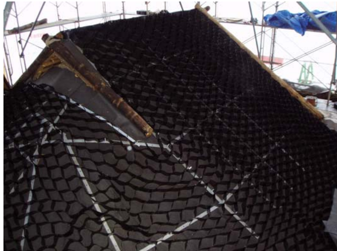
土屋根に浸透した雨水対策のシート等を敷設した後、草が定着しにくく、亀裂が生じやすい赤土が流出しないよう、ハニカム状型枠を屋根土層内部に使用しました。
