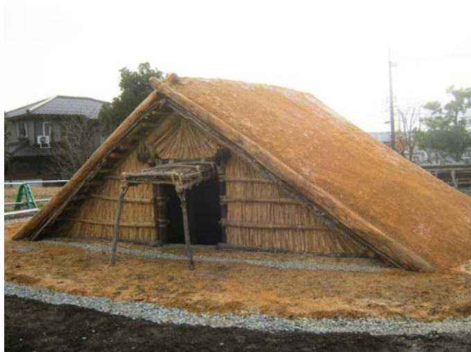
厚さ 15cm の土屋根は、最下層を全面軽石（大粒）層にして丸太材にかかる荷重を軽減させました。中層には小矢部市産の赤土と軽石（中粒）を混ぜて叩き締め、上層は赤土と軽石（細粒）を混ぜて叩き締めました。軽石は浸透した水を排出する空隙があり、これによって屋根土内を乾かすことができます。軽石には保水性もあり、夏季には散水することで屋根表面の細粒が若干の水分を保ち、赤土の亀裂を防ぐことにしました。
