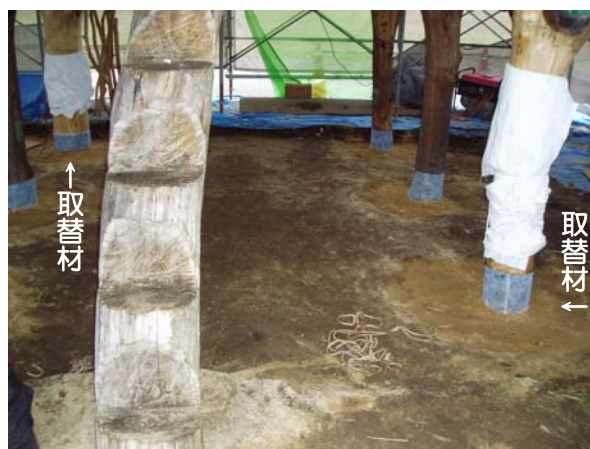
腐朽した主柱の取替状態（途中経過） —取替材のほか、再利用する主柱にも多様な耐久性向上策を施し、排水性の良い山砂で埋戻しました—
