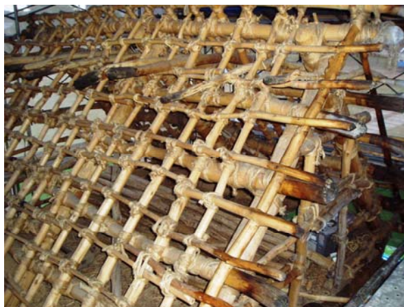
高床倉庫に葺かれた茅を除去した状態 —腐朽・虫害が進行した丸太材等を取替えます—
