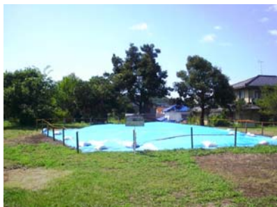
写真6 現地作業後の現況
