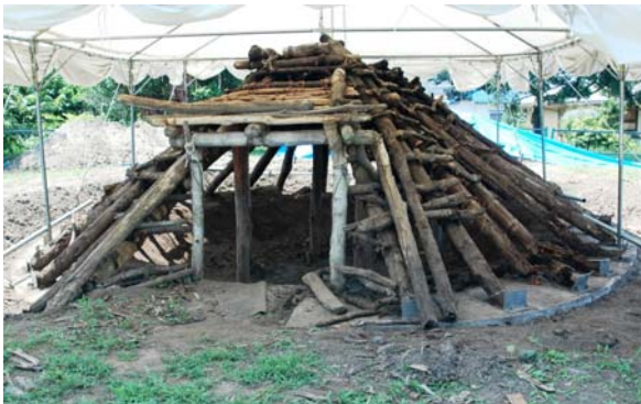
写真2 屋根に被せてあった土を除去した段階
