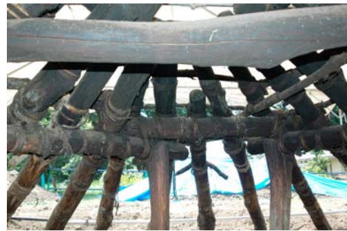
写真3 建築材上部の現況
