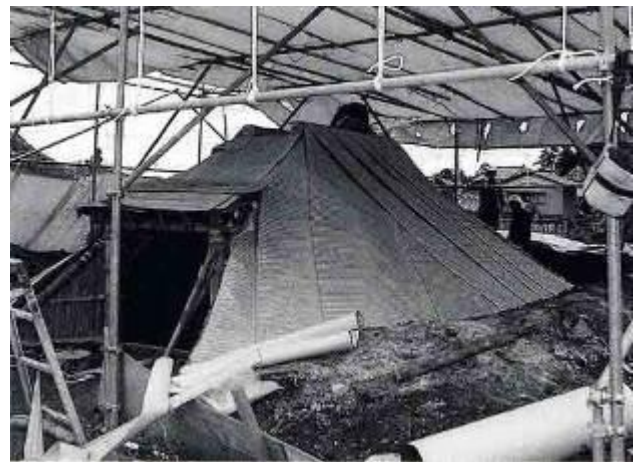
防水シートを敷設した状態(13号住居)
