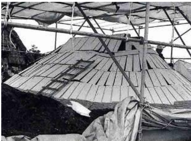
調湿建材を敷設した状態(13号住居)
