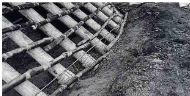
垂木尻に防水シートを巻きつけた状況 (1号住居)
