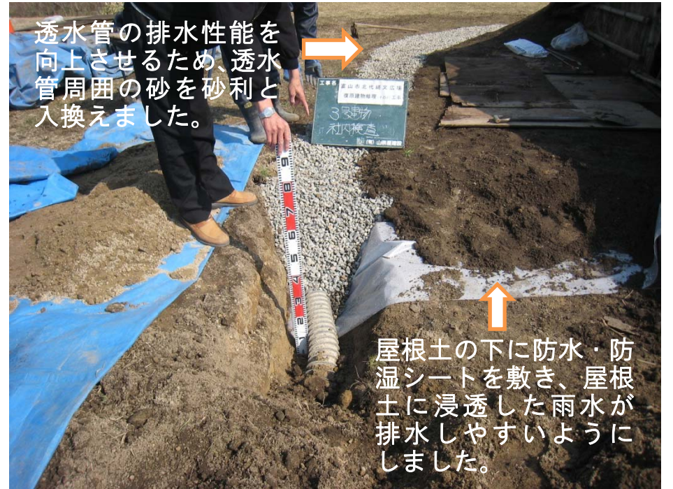
2.排水対策（平成24年度修理）
