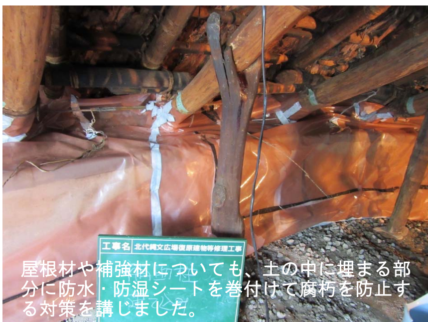
5.屋根材の養生
