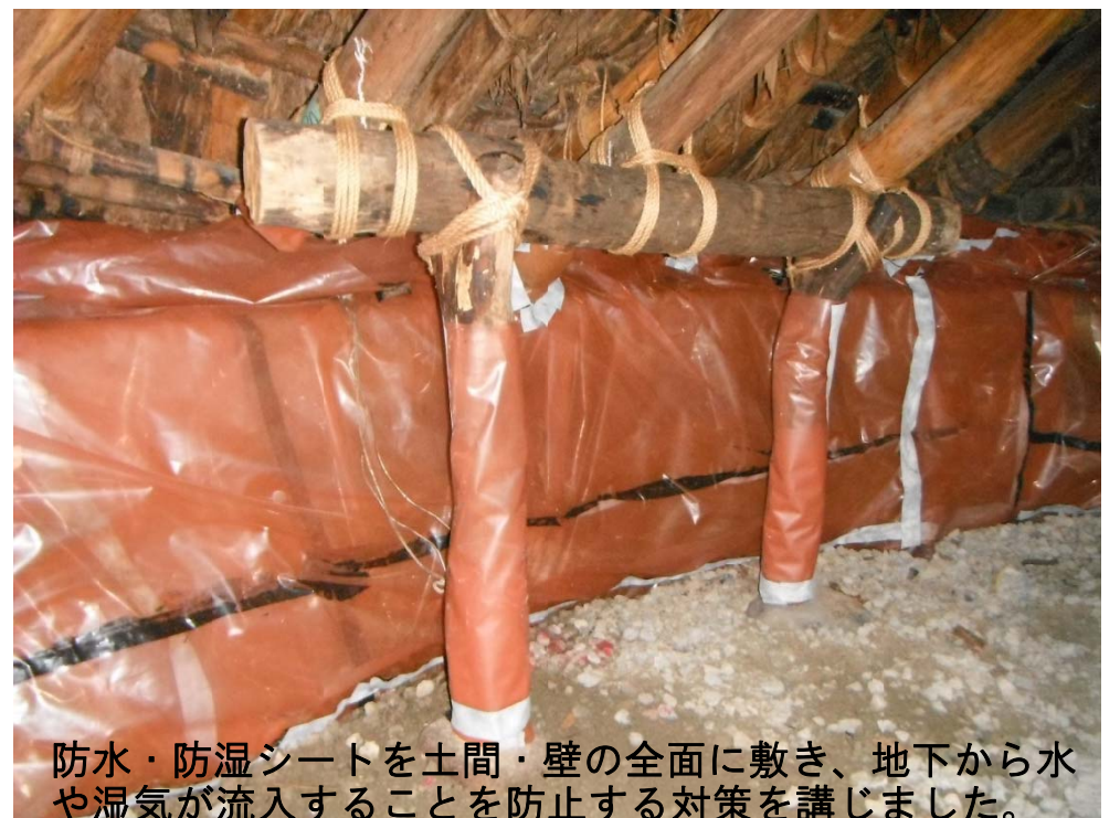
4.防水・防湿シートと屋根材の補強
