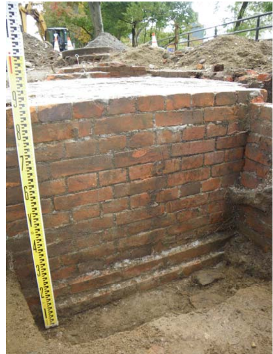
②議事堂付属建物の煉瓦積み（イギリス積み）
