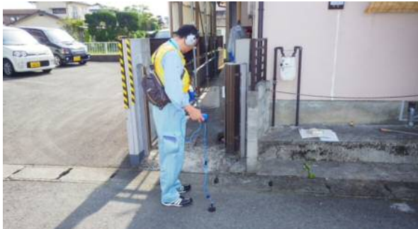
5/4 熊本県熊本市出水町での漏水探知機による調査状況
